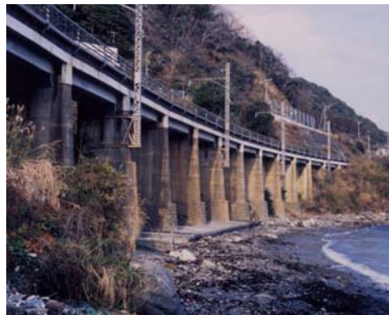
(a) 山生橋梁 2)
